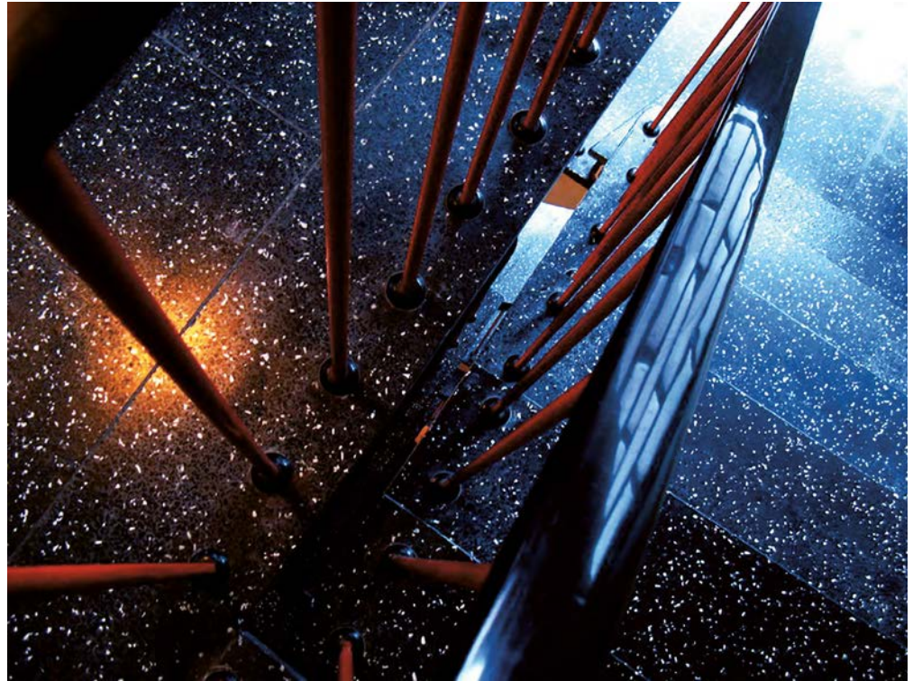
Die Beleuchtung muss stimmen, damit das Treppenhaus nicht zur Stolperfalle wird.
