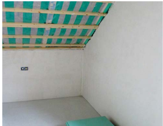
Die richtige Dämmung ist eine Aufgabe für Fachleute.
