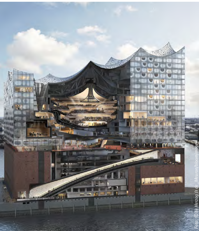
Der Blick ins Innere des Bauwerks zeigt, dass der große Konzertsaal nur einen Teil des Gebäudes ausmacht.
