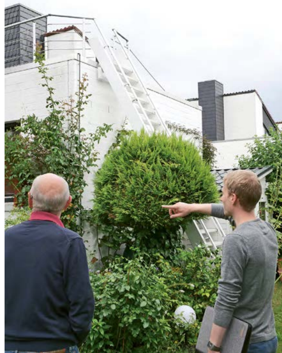
Ist das Dach geeignet für eine Fotovoltaik- oder Solarthermie-Anlage?
