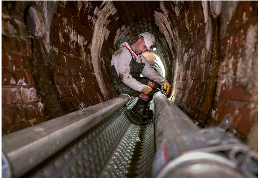
In einem Barmbeker Neubauquartier werden 149 Miet- und Eigentumswohnungen mit Abwasserwärme aus dem Siel beheizt.
