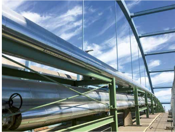
Aurubis versorgt etwa 9.000 Wohnungen und Bürogebäude in der östlichen HafenCity, auf der Veddel und in Rothenburgsort mit Industriewärme.
