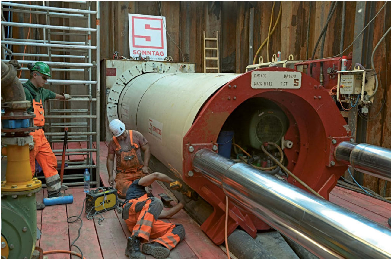
Tunnelvortrieb für das Hamburger Wasserstoff-Industrie-Netz HH-WIN unter dem Altenwerder Hauptdeich
