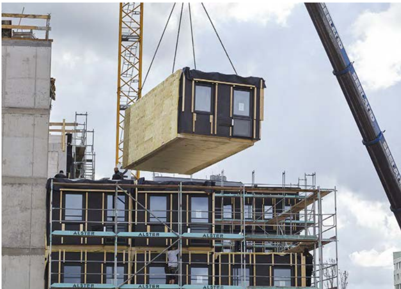
Das 2017 fertiggestellte Studentenwohnheim Woodie in Wilhelmsburg entstand aus 371 vorgefertigten Wohnmodulen.
